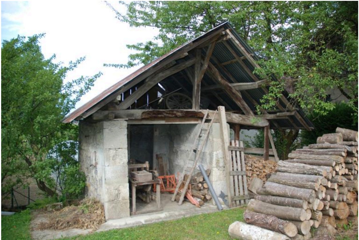
Vue du four à pain.
