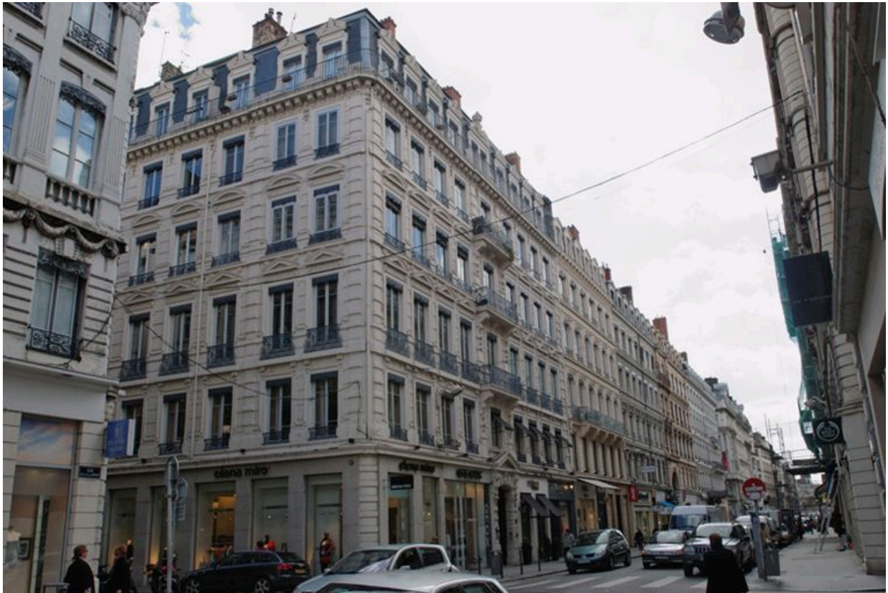
Vue de la rive impaire en direction du sud à partir de la rue Ferrandière
