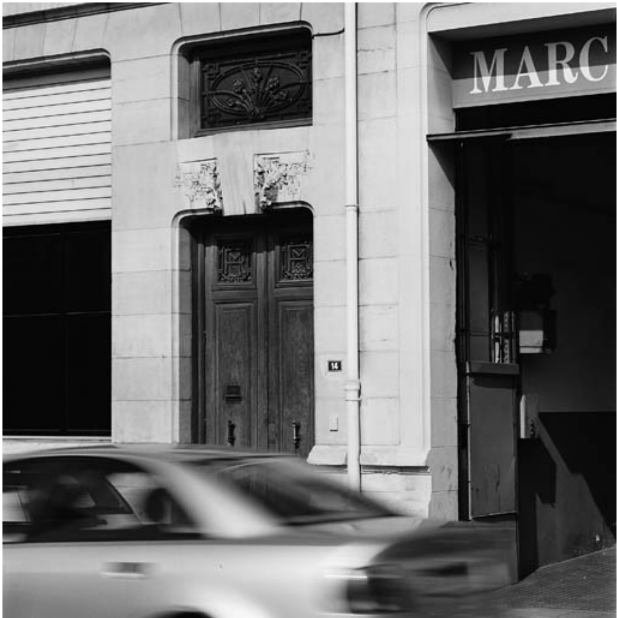
Porte d'entrée, vue d'ensemble
