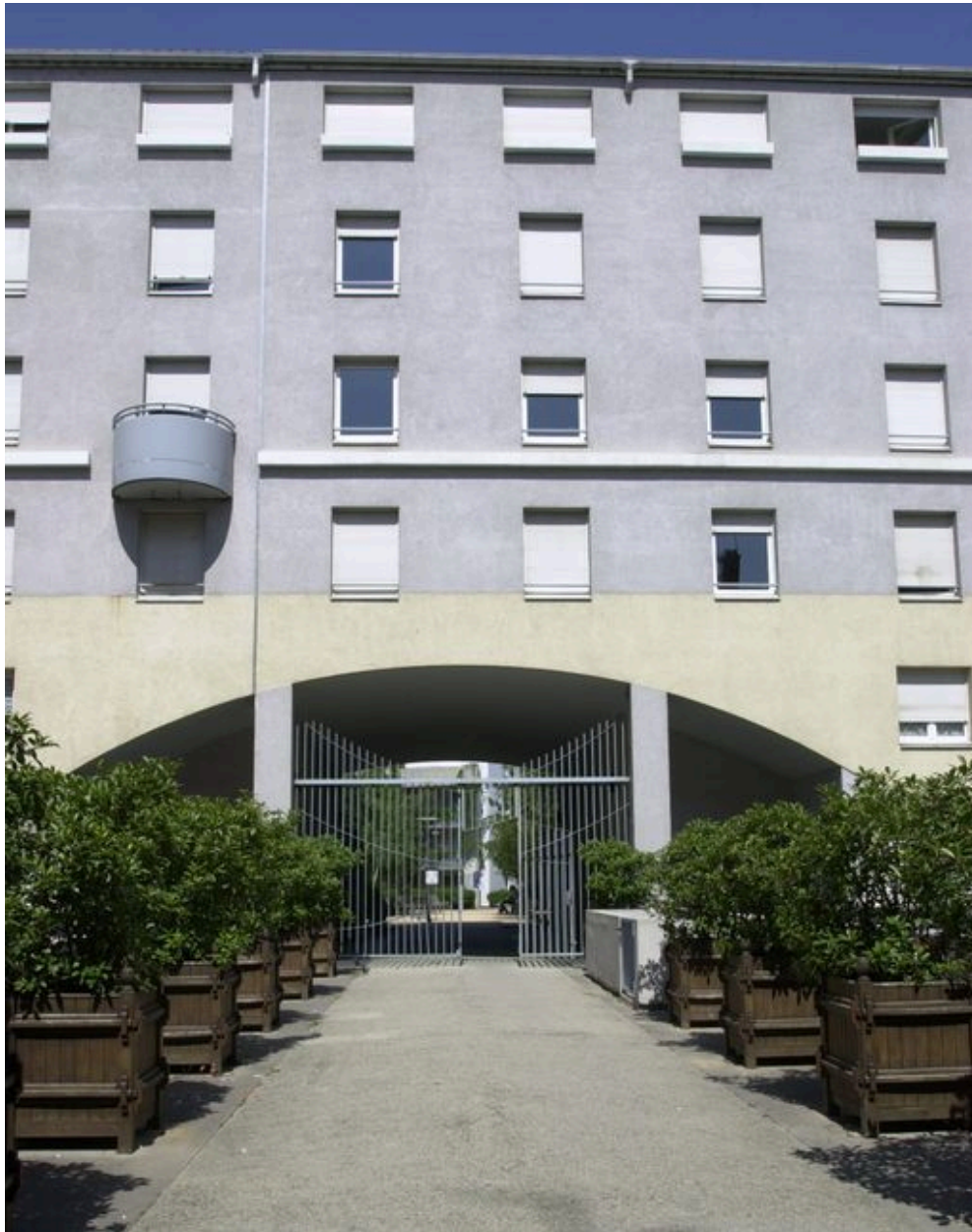
Détail de la travée centrale avec passage cocher vers le square en coeur d'îlot, rue Sébastien-Gryphe
