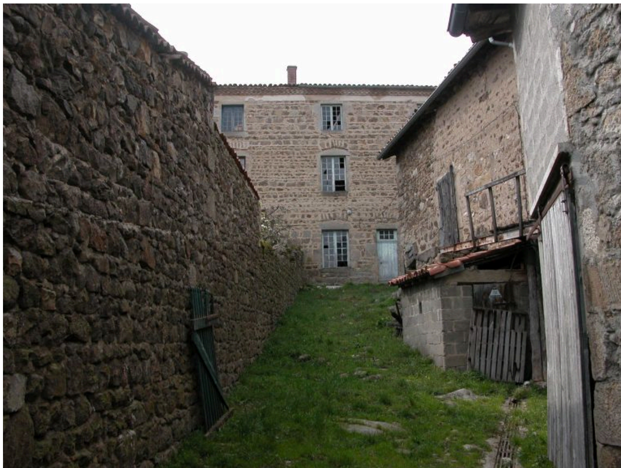
Vue rapprochée de la cour de la parcelle 259.
