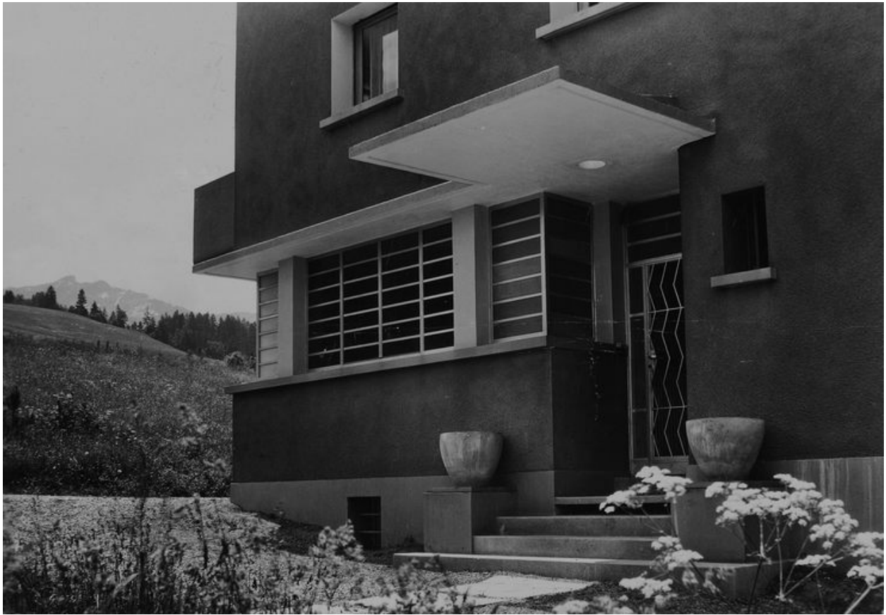
Façade antérieure. Angle nord-est. Photogr. Georges Tairraz, Chamonix, [milieu XXe siècle] (AD Haute-Savoie. 142J 575)
