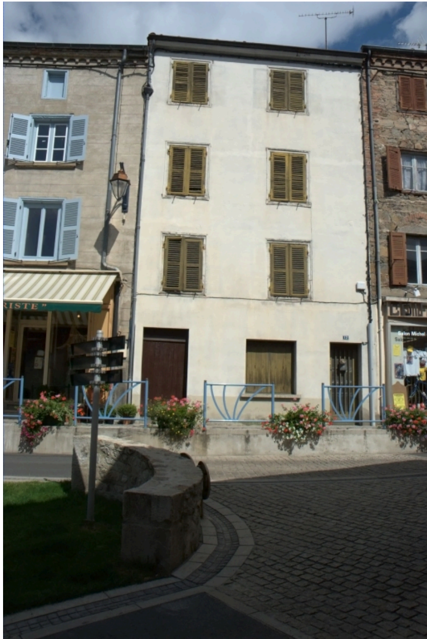
Îlot 3. Victoire (place de la) 12. Vue générale de la façade sur rue.
