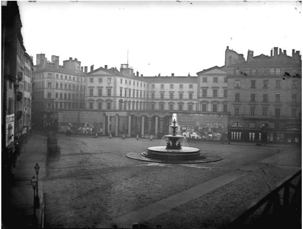
Vue de situation de la première fontaine installée sur la place de 1853 à 1866. fotogr. Nég. sur verre AM Lyon. 3 Ph 00440
