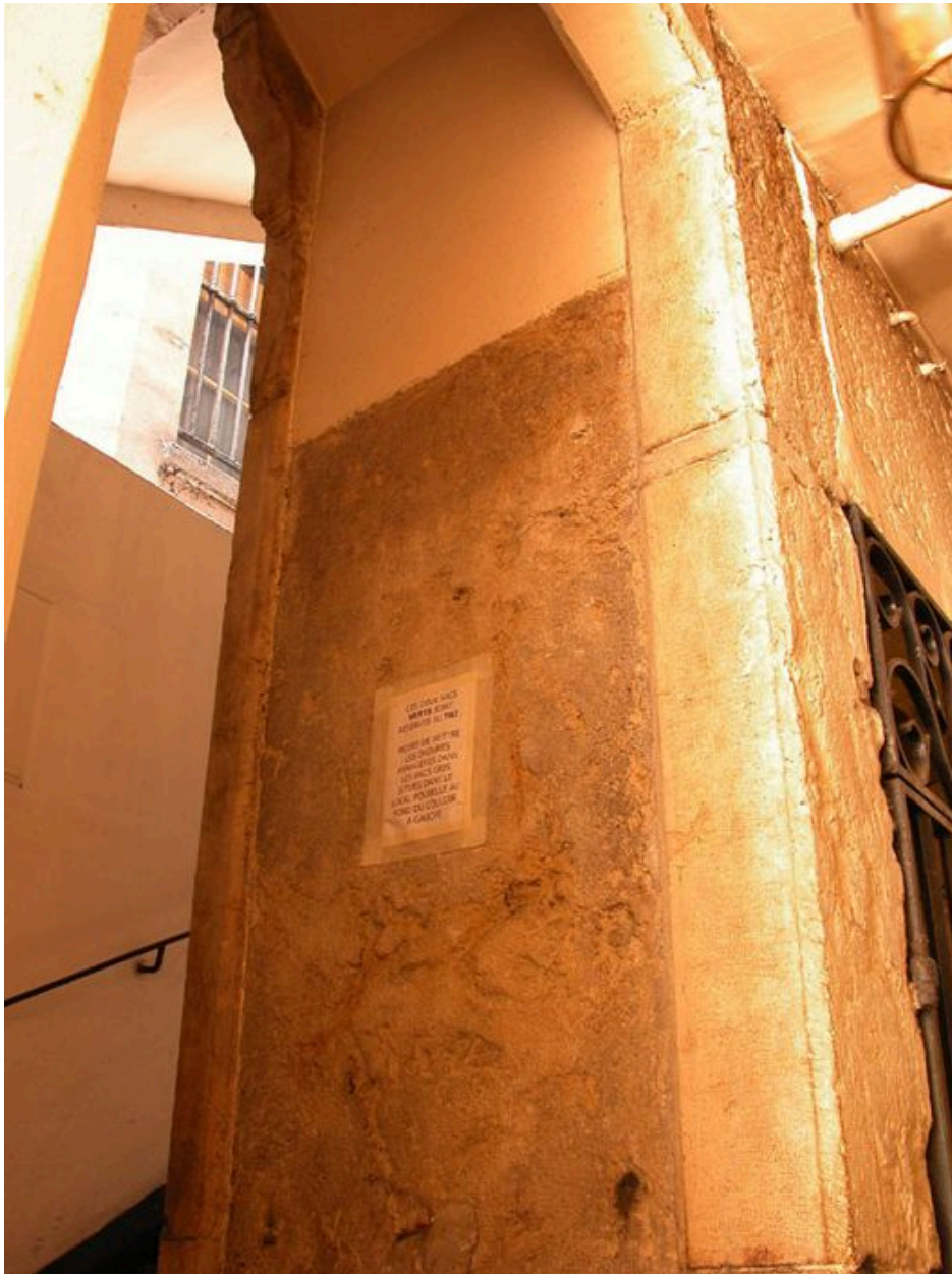
Noyau de la cage d'escalier
