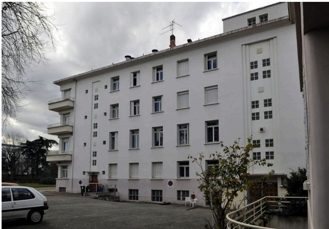
Aile sud, façade est
