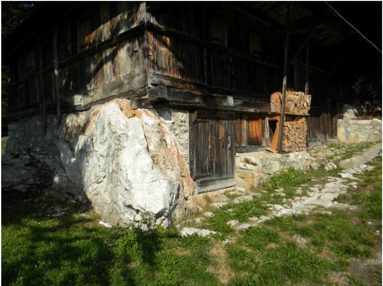
Détail d'un rocher servant d'appui au bâtiment
