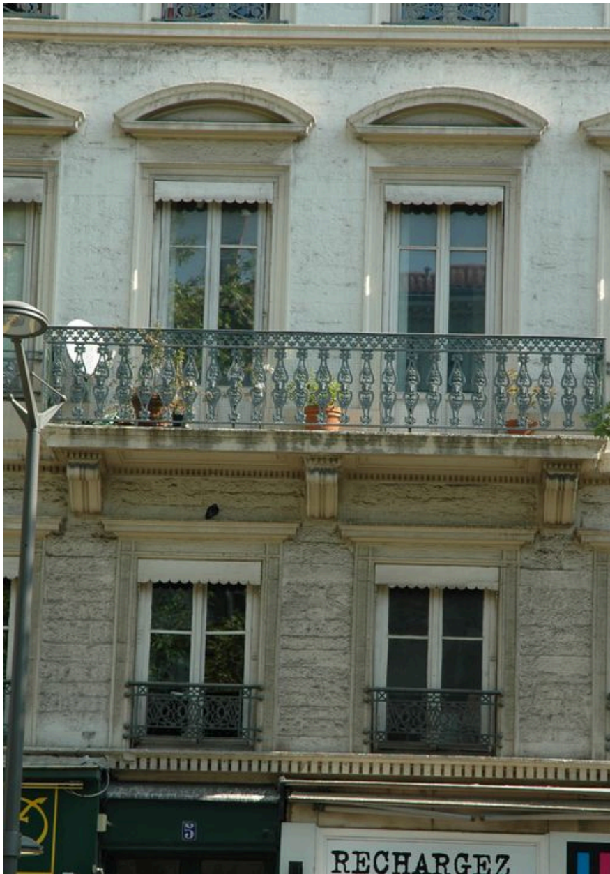
Détail de deux travées de fenêtres
