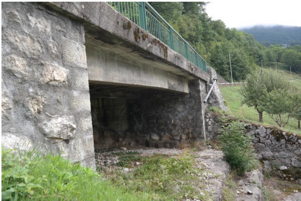
Pont du Fontanil, vue de la face aval
