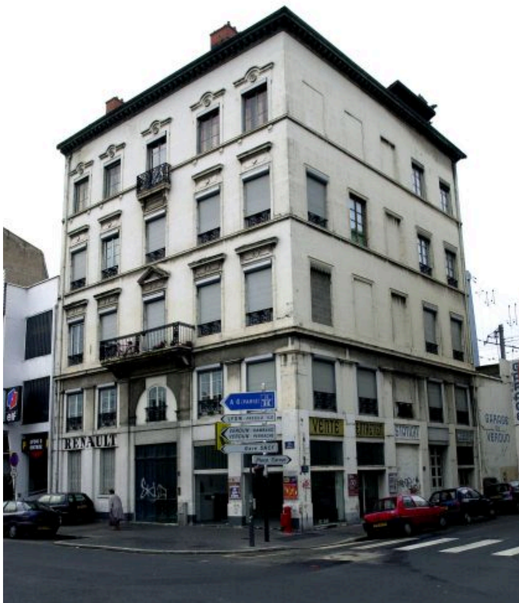
4 cours de Verdun-Rambaud, immeuble à passage cocher centré et entresol
