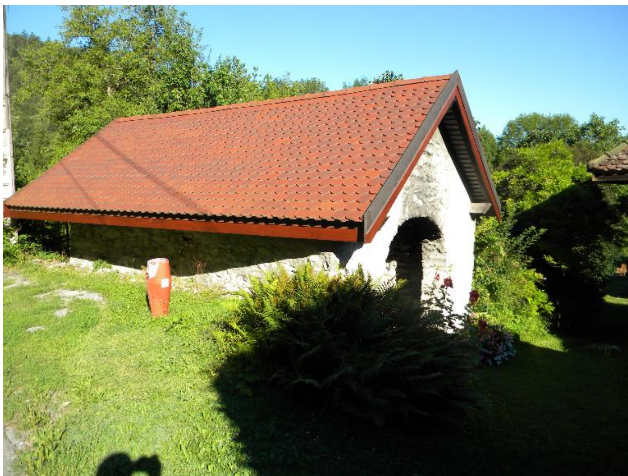
Vue d'ensemble du four.
