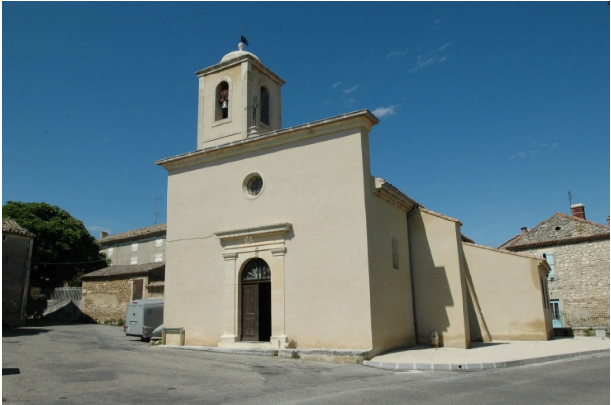
Place de l'Eglise, vue sud-ouest de la façade de l'église.
