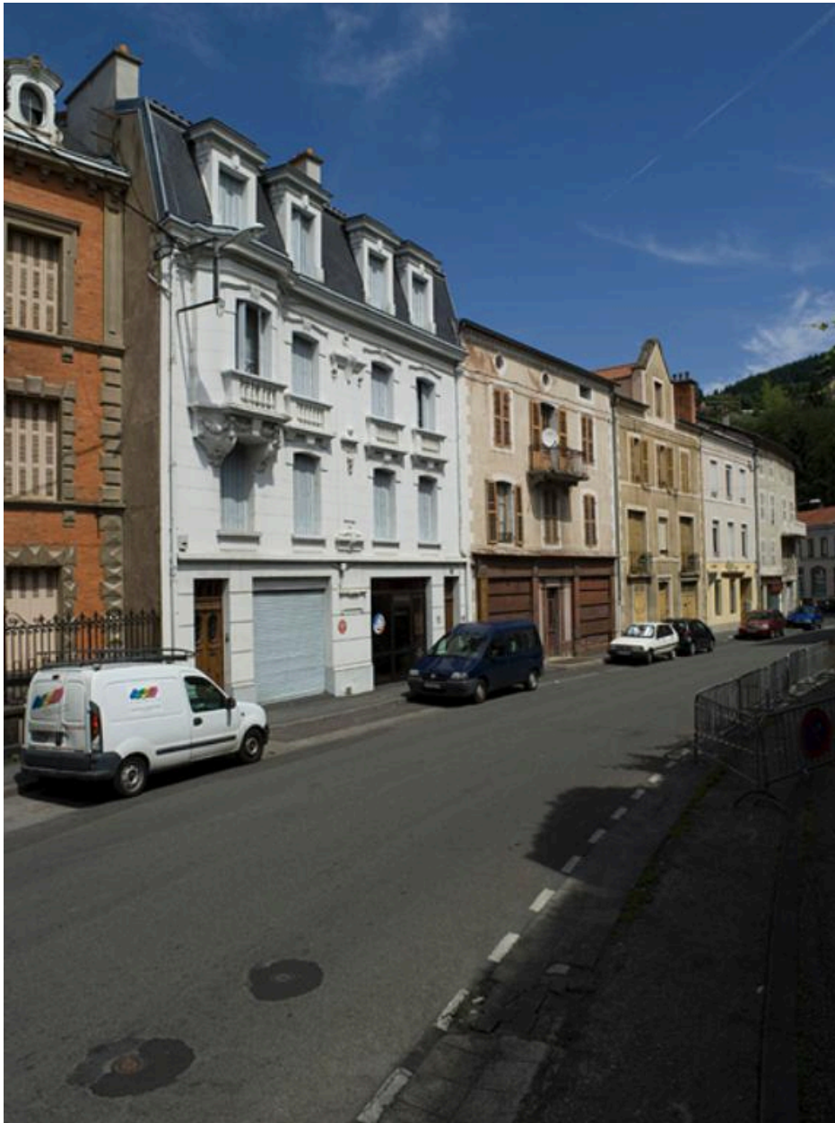
Exemple de bâti perpendiculaire à la pente, rue des Docteurs-Dumas.
