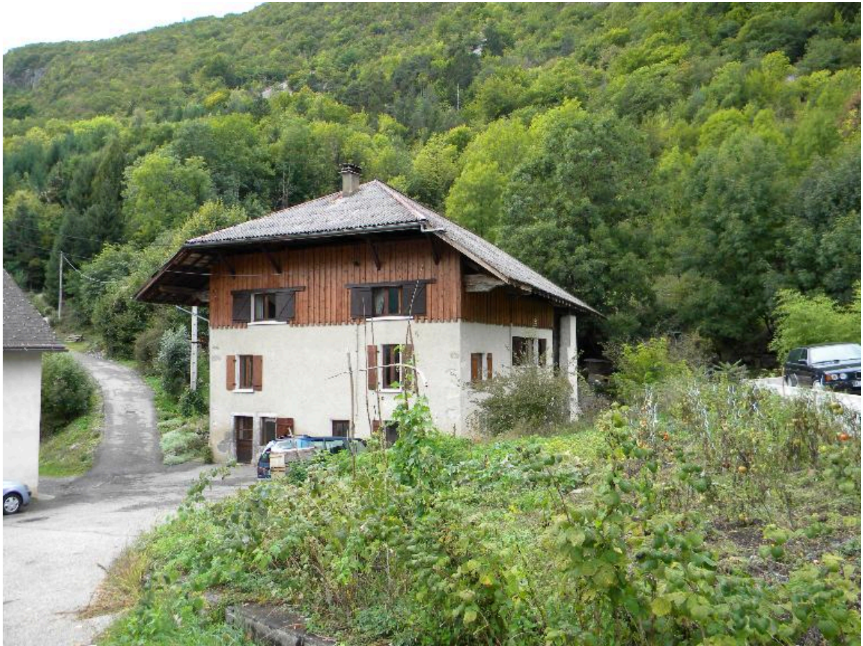
Vue de trois-quarts d'une ancienne ferme (2008 C3 300)
