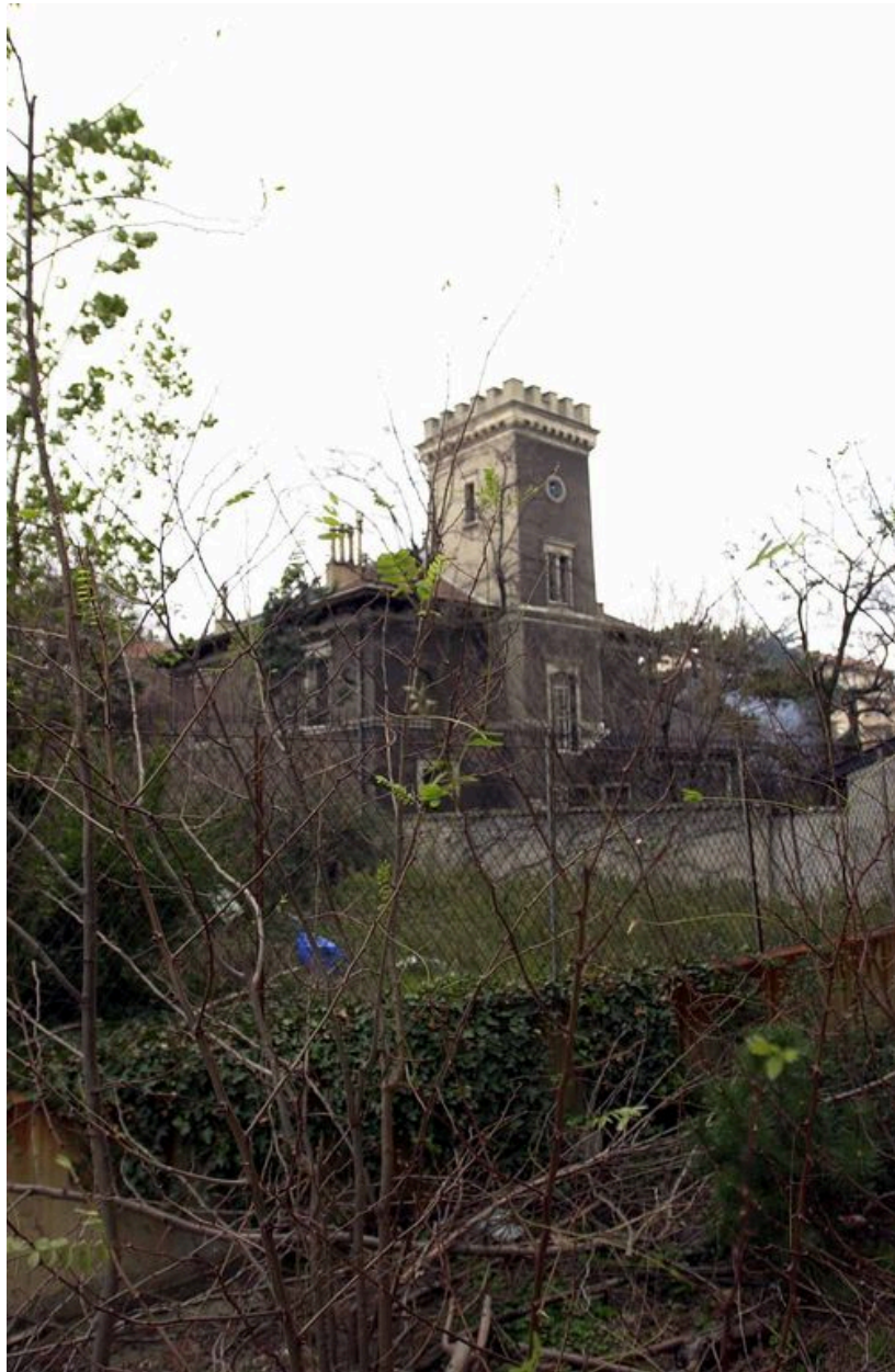
Logis, vue générale de la façade arrière
