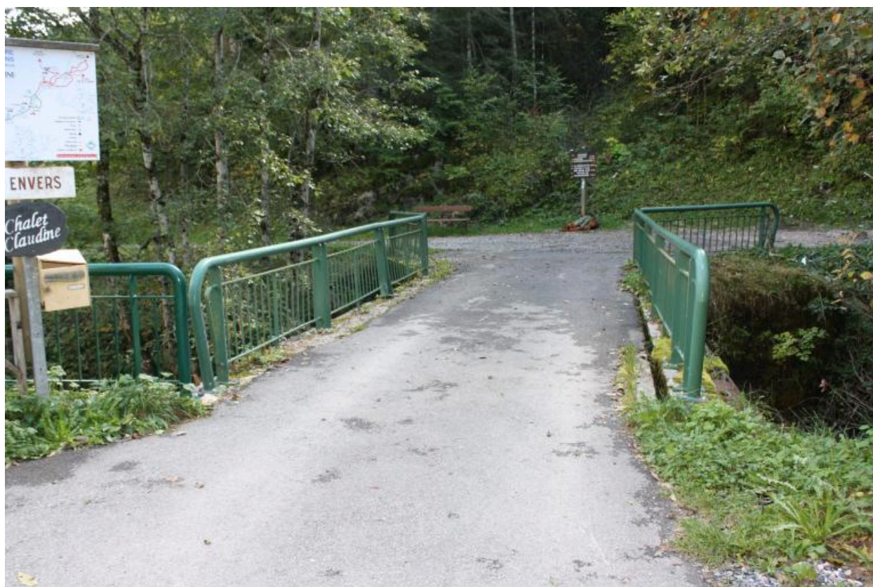
Pont de l'Envers, chaussée et gardes corps
