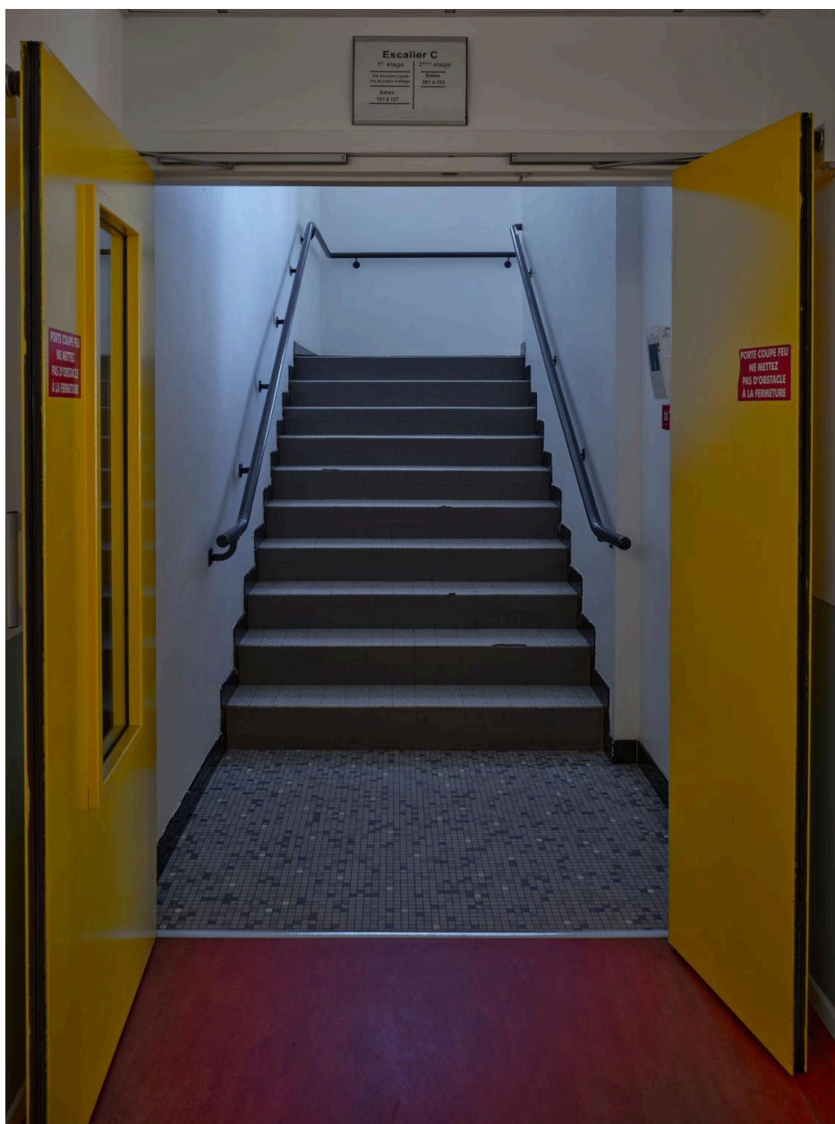
Bâtiment B. Escalier rampe-sur-rampe, actuellement isolé du couloir par une porte coupe-feu.
