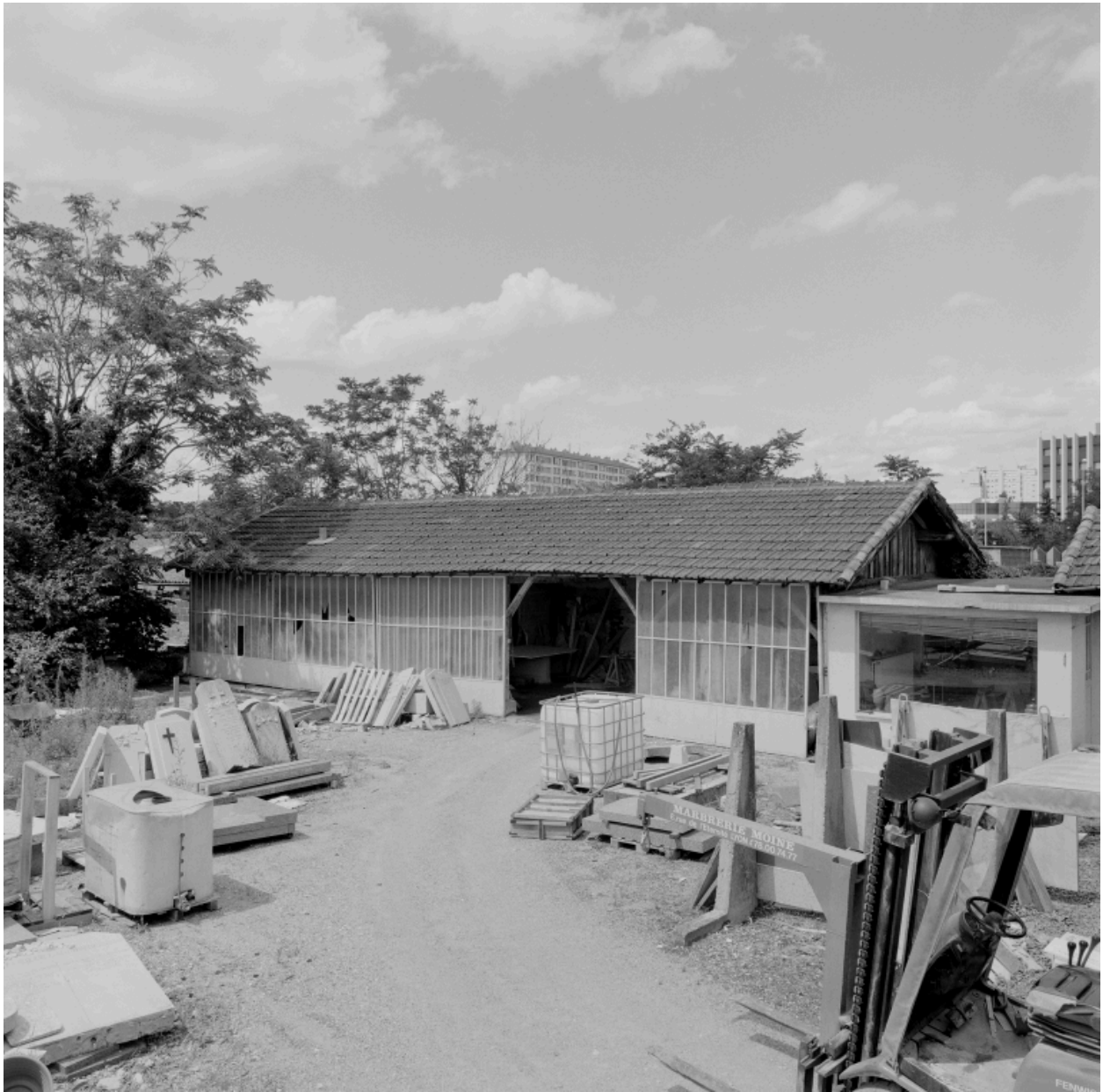
L'atelier de taille de pierre : vue extérieure
