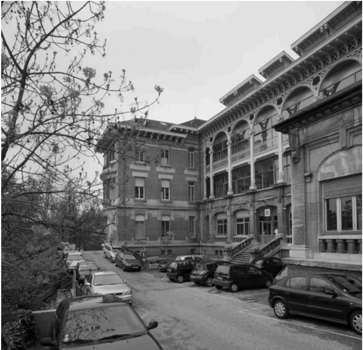
Bâtiment B, façade principale, partie sud
