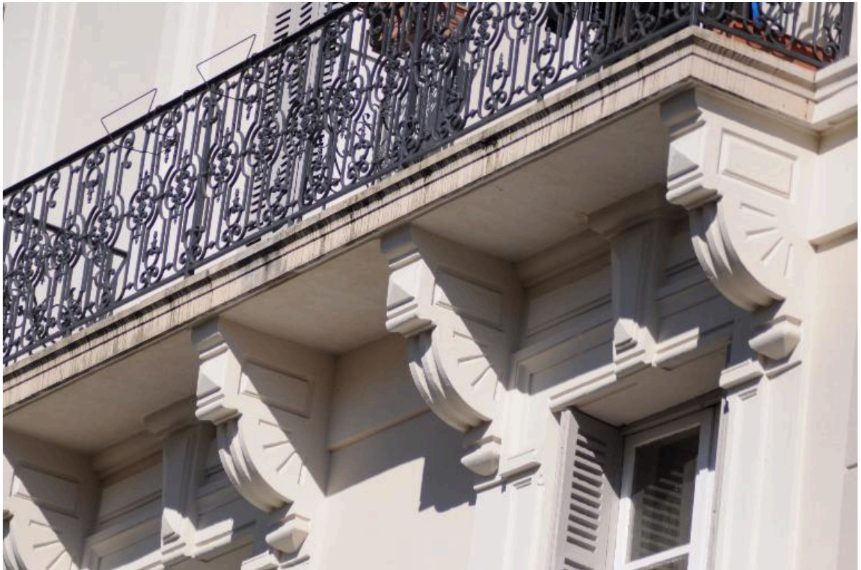
Dessus-de-fenêtres des baies du 1er étage et consoles des balcons du 2nd étage
