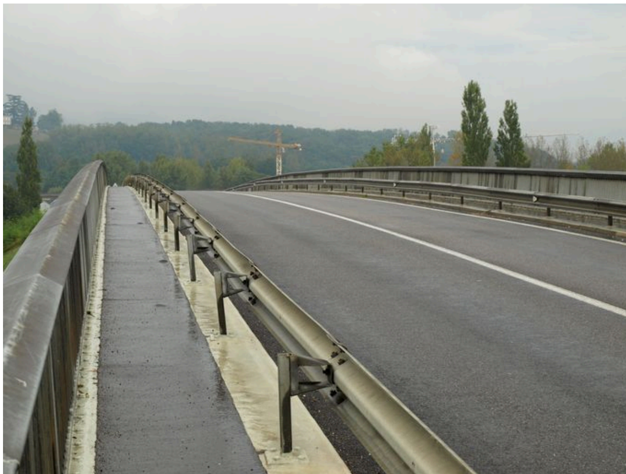
Tablier : vue de la chaussée
