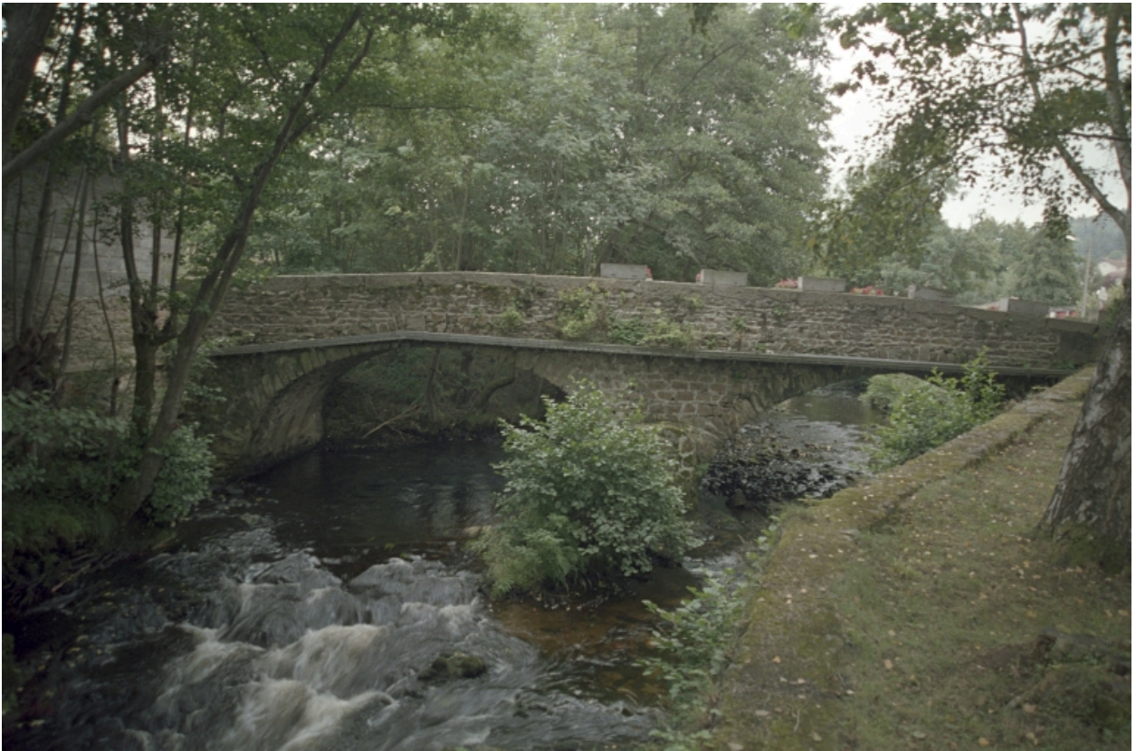
Pont traversant le Lignon au lieu-dit Marancey, vue d'ensemble.
