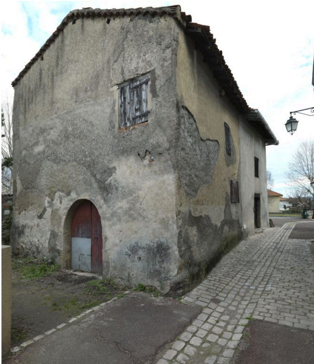
1986 AE 124, 125. Cuvages, vue d'ensemble de trois-quarts sud-ouest.
