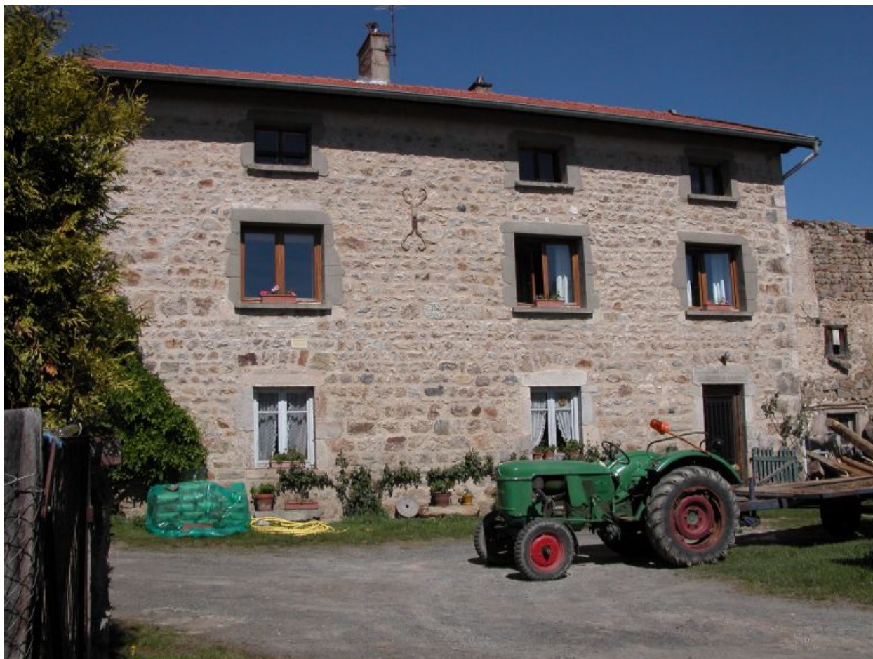
Vue d'ensemble du nouveau logis de la ferme.
