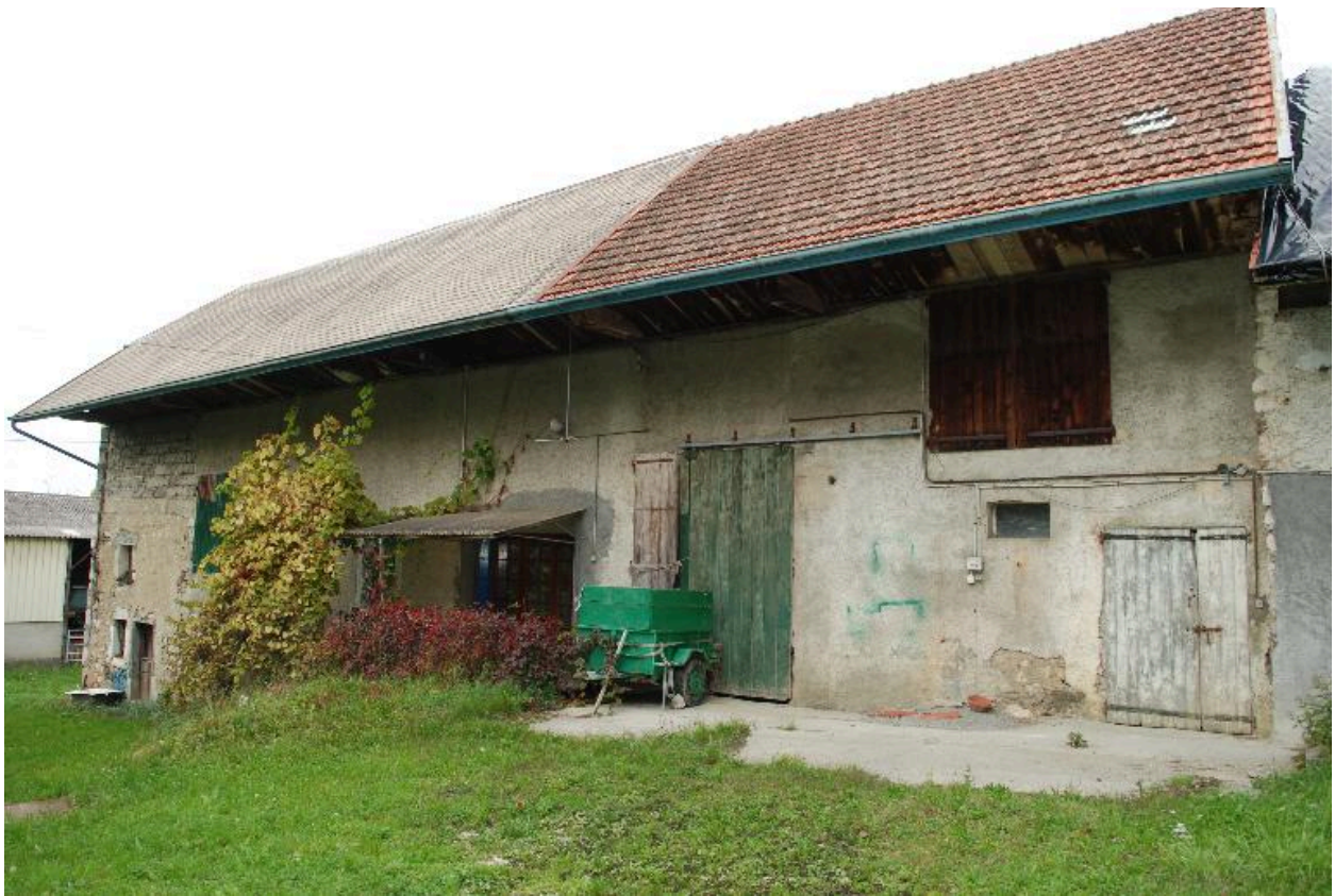
Vue d'ensemble de la partie gauche (ouest) de la ferme.
