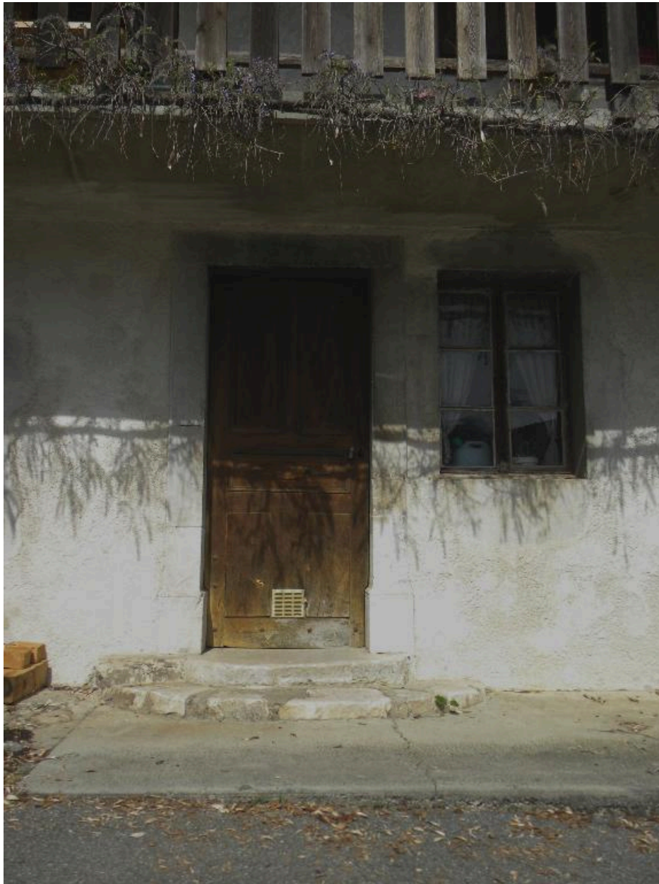
Vue d'un encadrement de portes et fenêtres d'une maison modifiée (2008 A3 1483)
