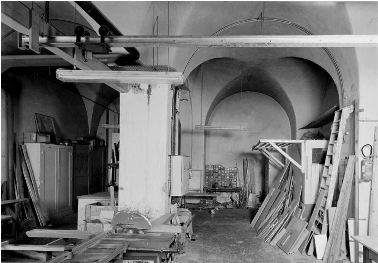
Bâtiment de la Buanderie (26), étage de soubassement, partie ajoutée en 1844-1845 pour le service des bains des aliénés
