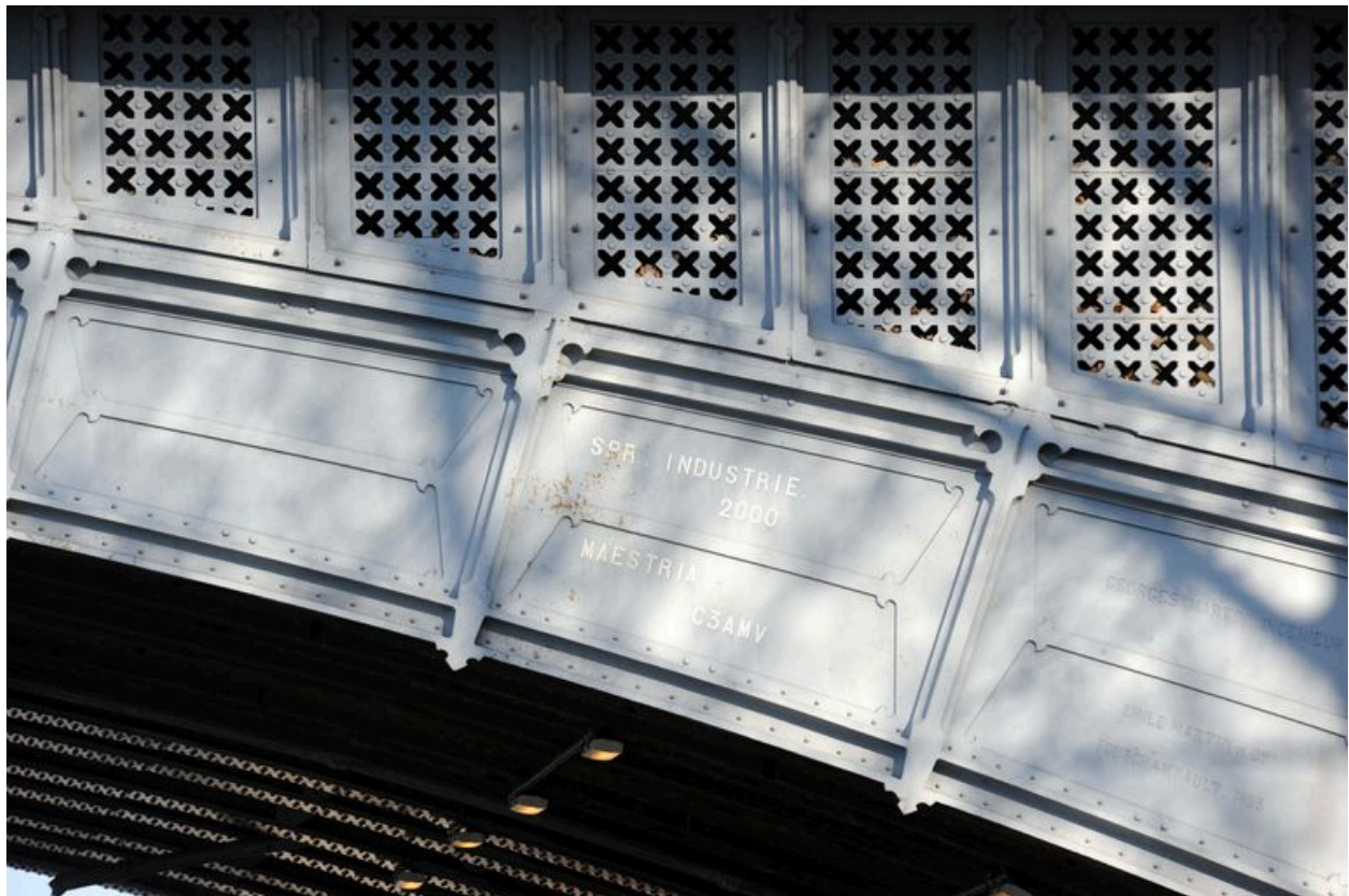
Arche en acier, face aval, vue de détail (depuis la rive gauche)
