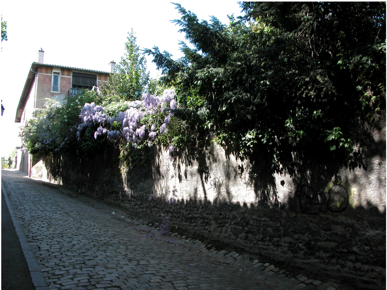
Vue en contrebas de la face antérieure
