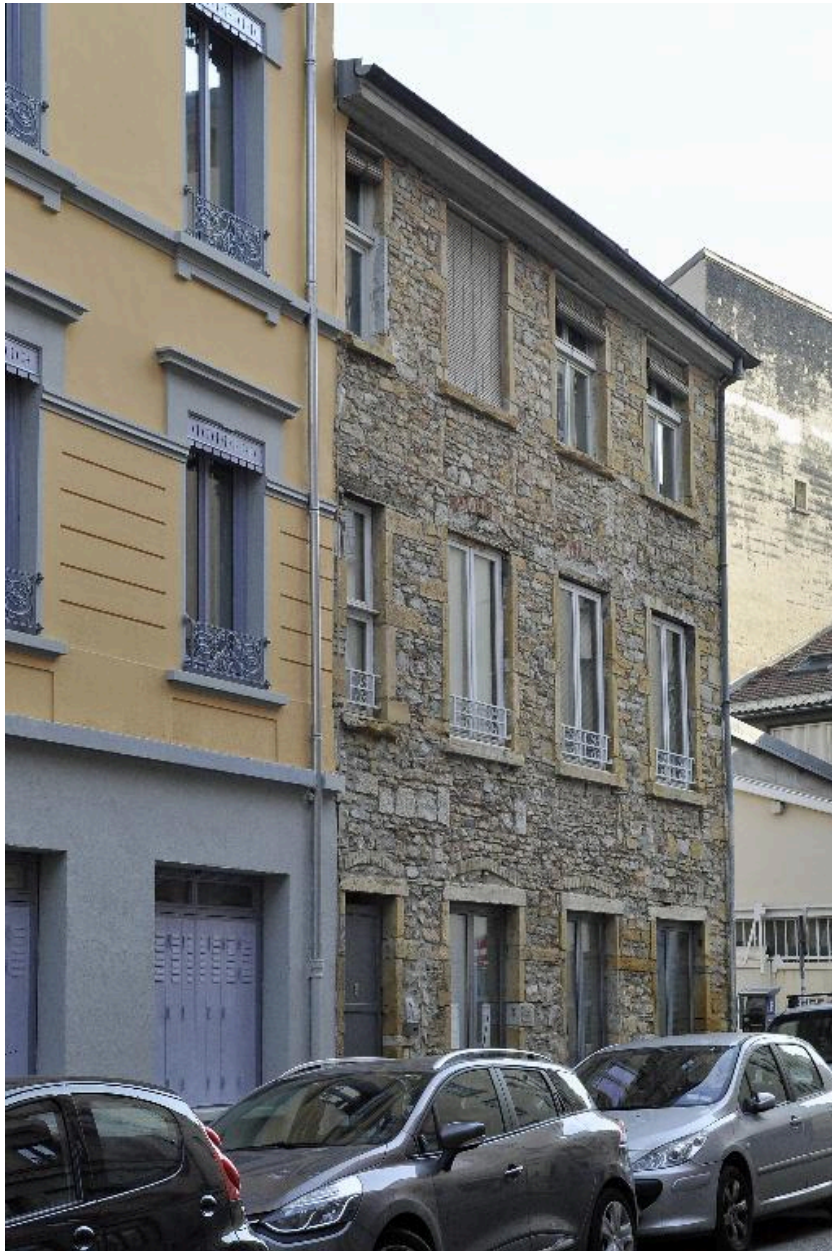
Bâtiment d'angle, élévation principale rue de la Thibaudière
