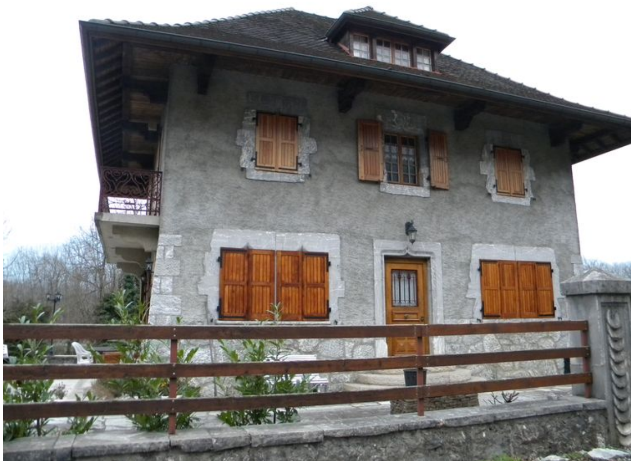
Vue générale, façade d'entrée.
