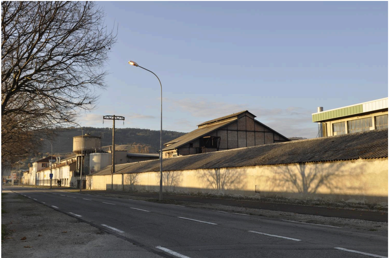
Vue d'un des deux longs bâtiments de 100 m et de la chaufferie.
