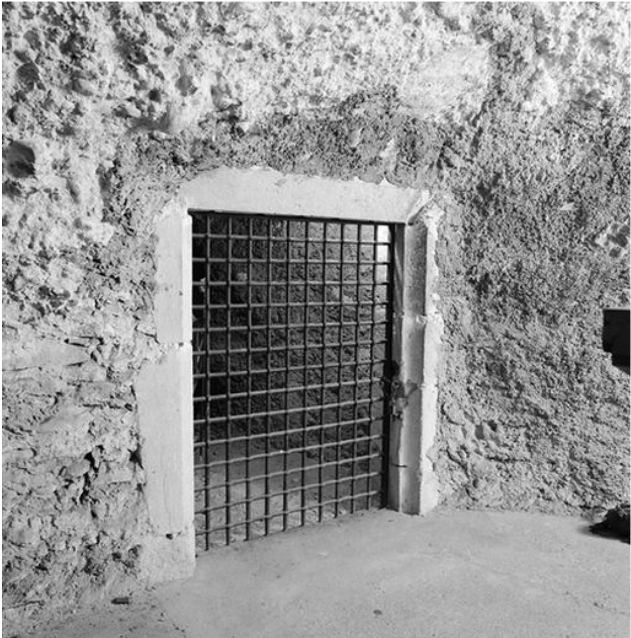
Caveau, entrée de la cavité ouest
