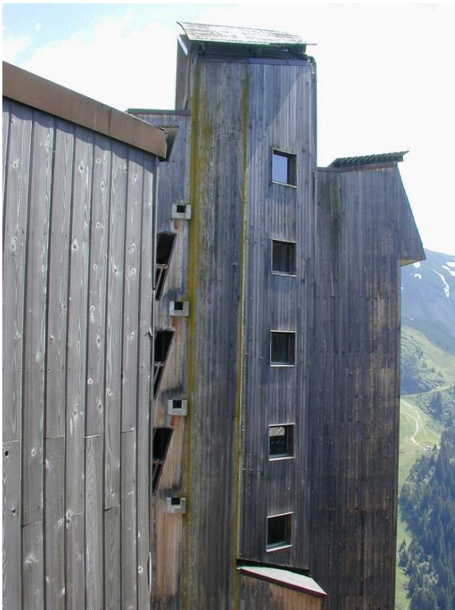
Vue d'ensemble du pignon ouest
