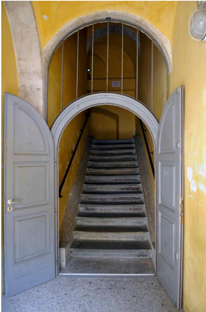
Bâtiment F : porte ouvrant sur la première volée de l'escalier
