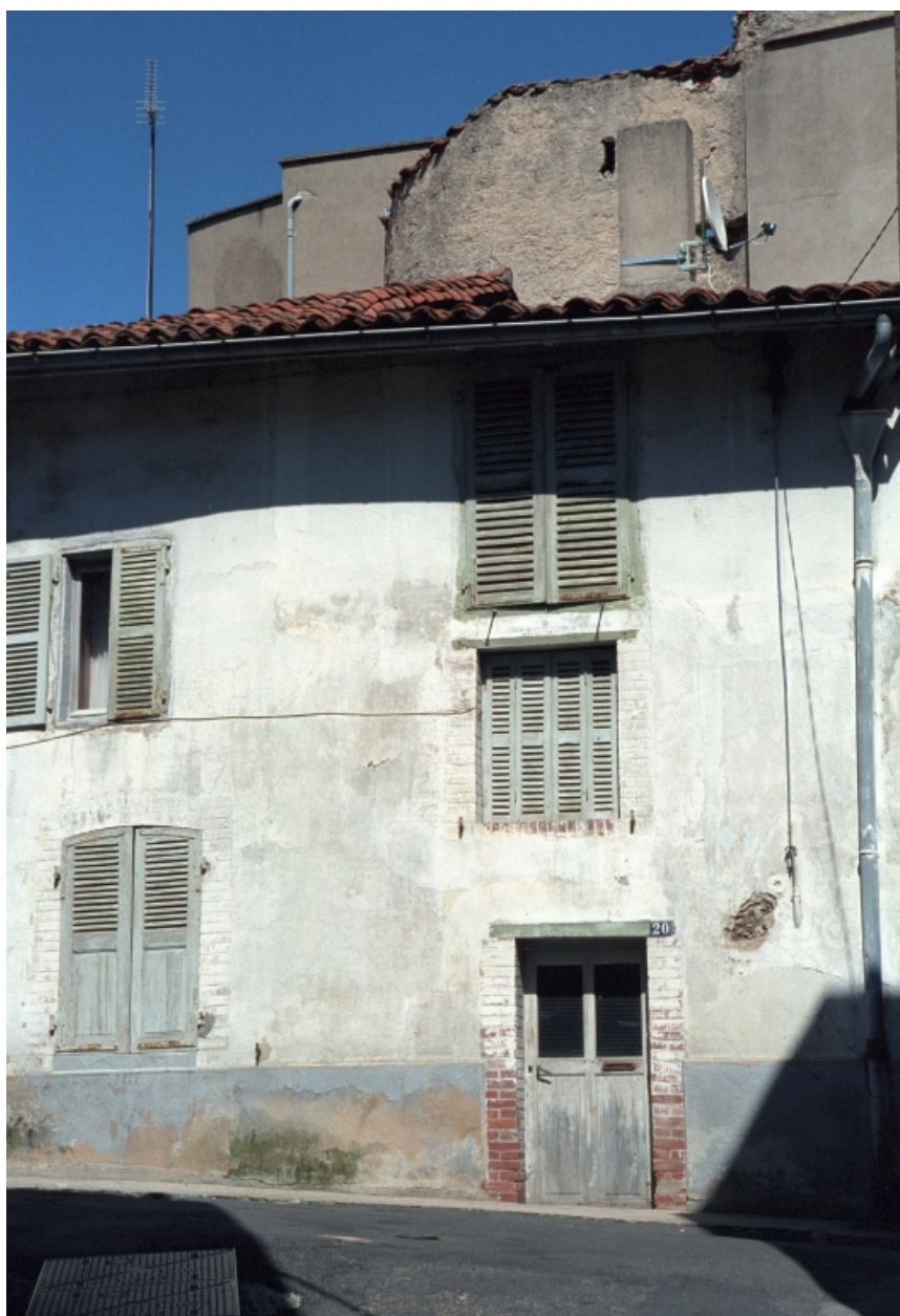
Boën, îlot 14, Gustave Labrosse (rue) 20. Vue générale de la façade sur rue.
