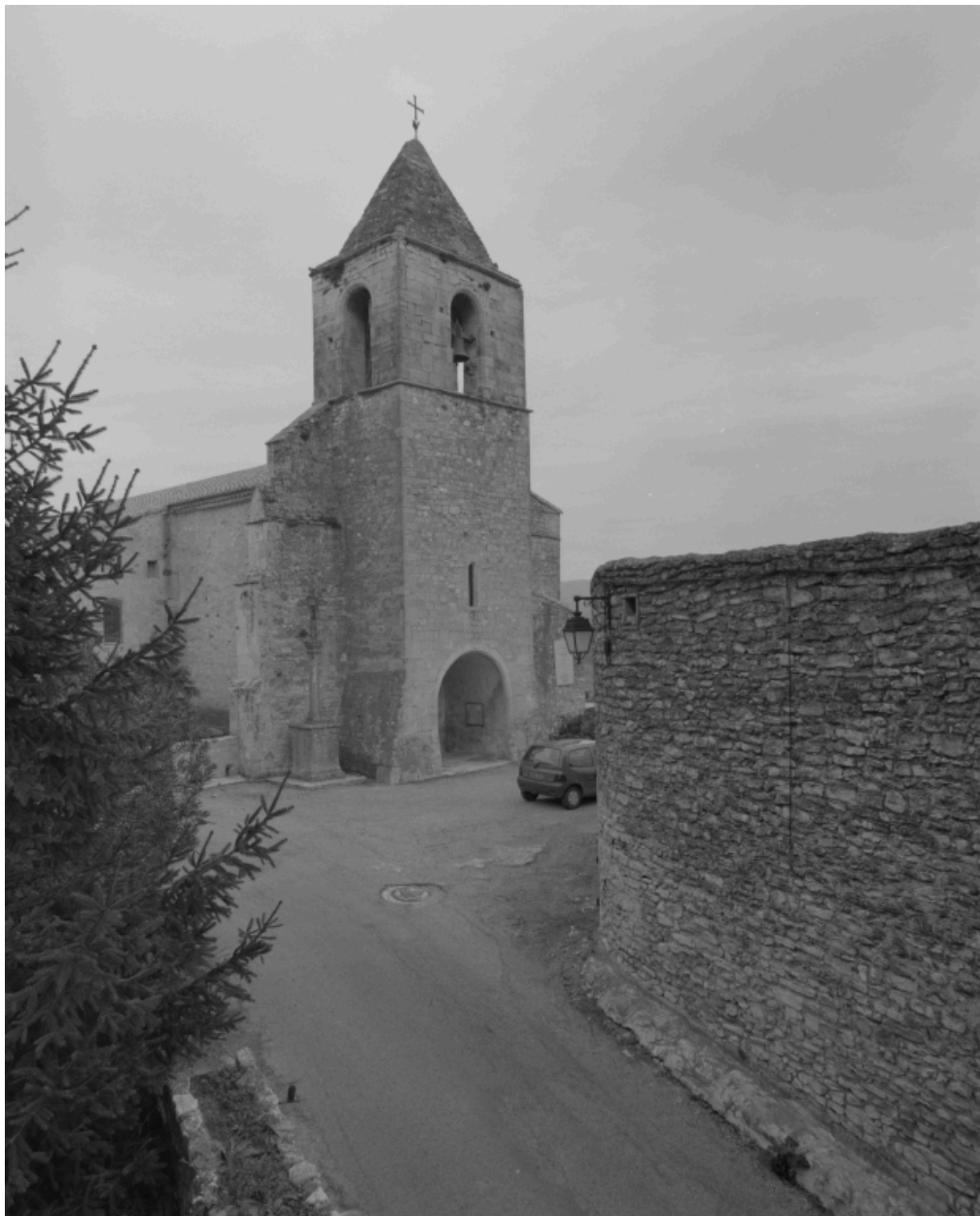
Façade occidentale, clocher-porche.
