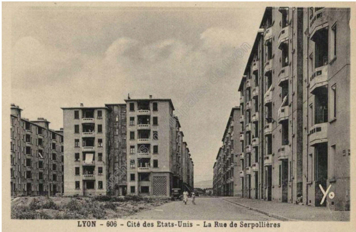
Carte postale de la cité en construction rue Serpolières vers 1930 (AC Lyon 4FI_335)
