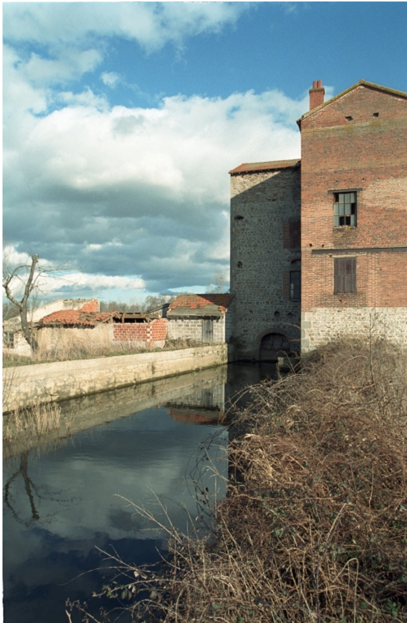
Vue d'ensemble de l'arrivée du bief sur la façade ouest du moulin.
