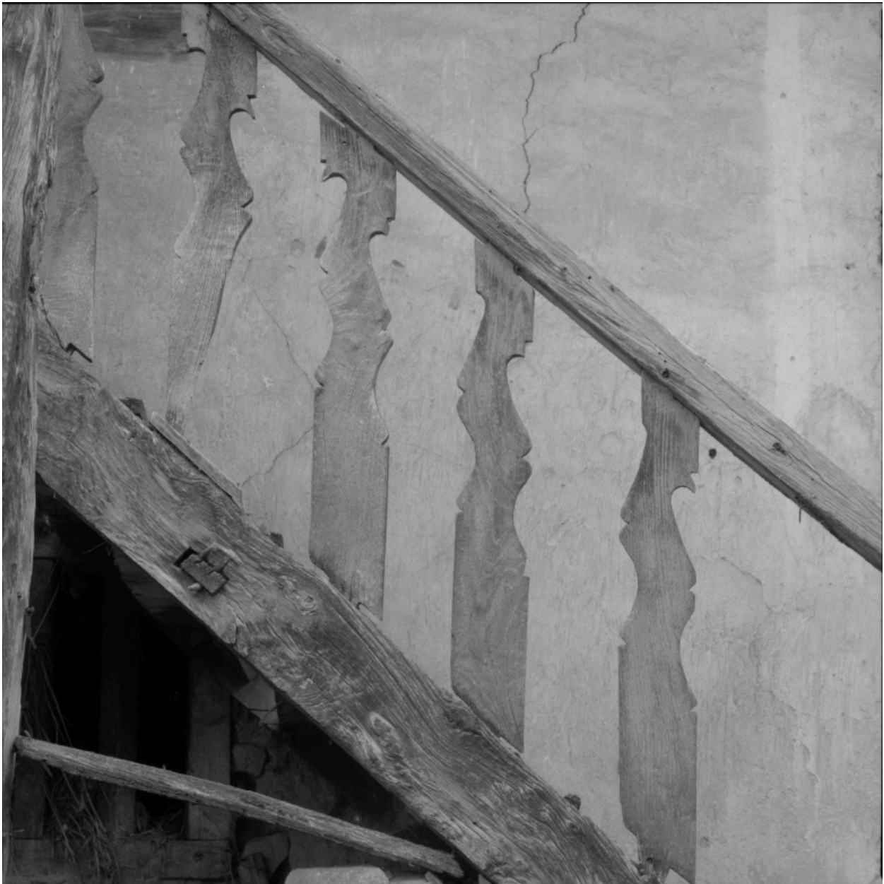
Logis ancien, vue de détail de la main courante de l'escalier.
