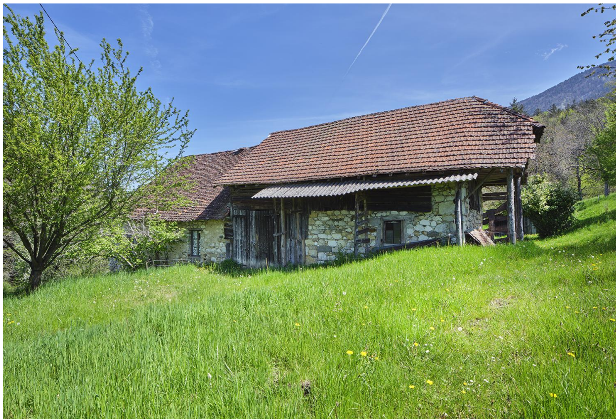
Vue d'ensemble de face de la façade nord de la ferme.
