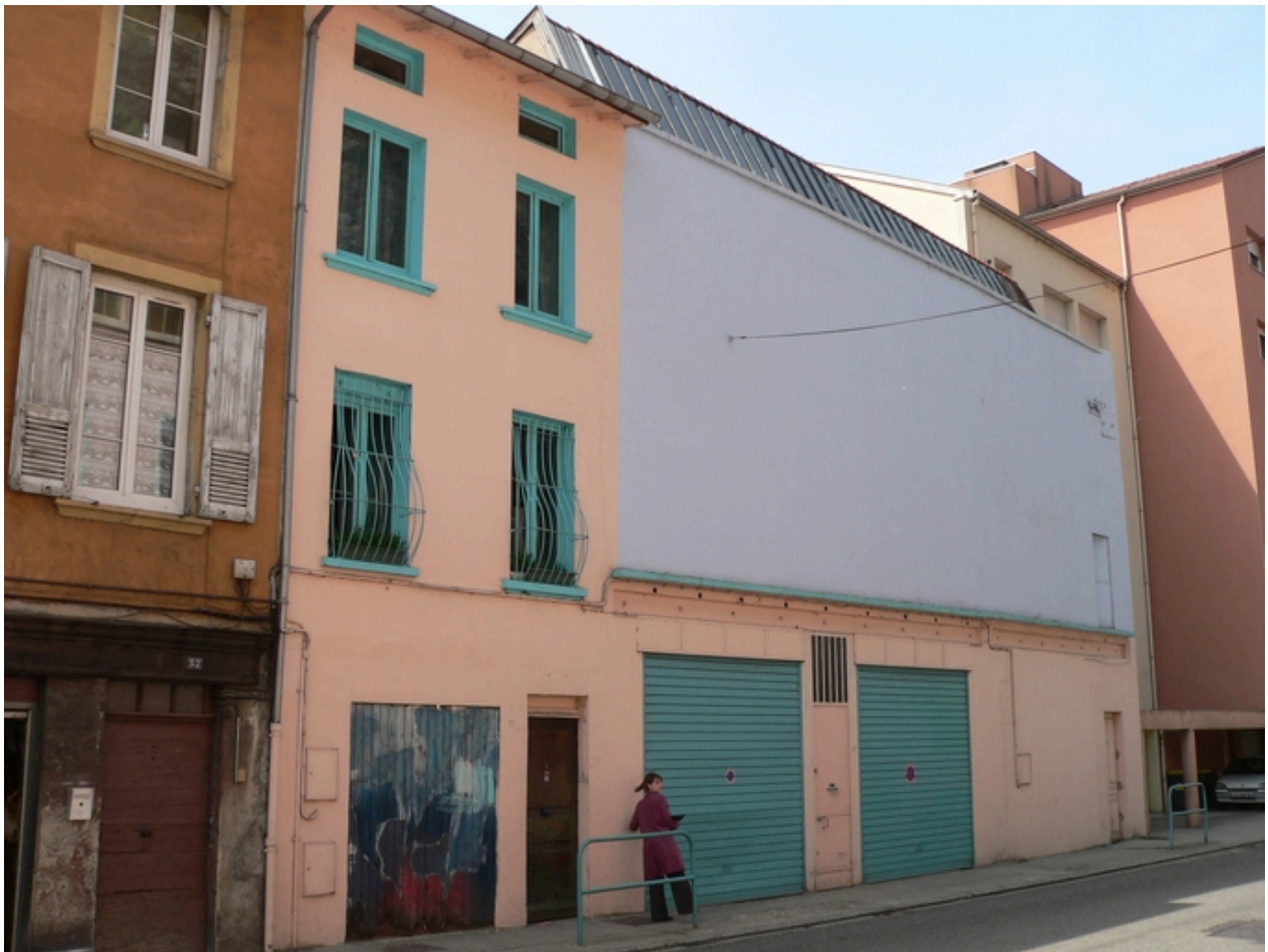
Façade principale sur rue
