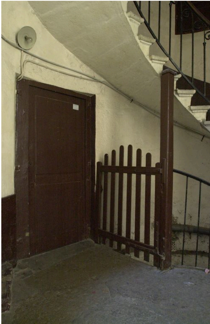
Entrée de cave sous l'escalier
