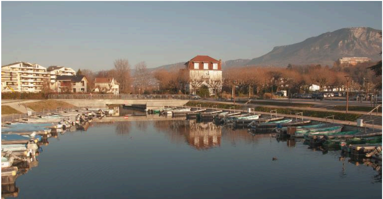
Vue générale depuis la rive
