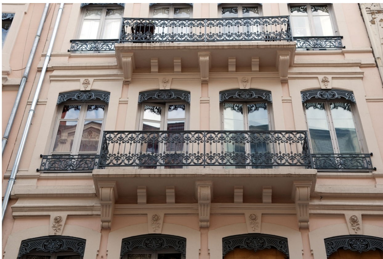
Elévation antérieure : détail
