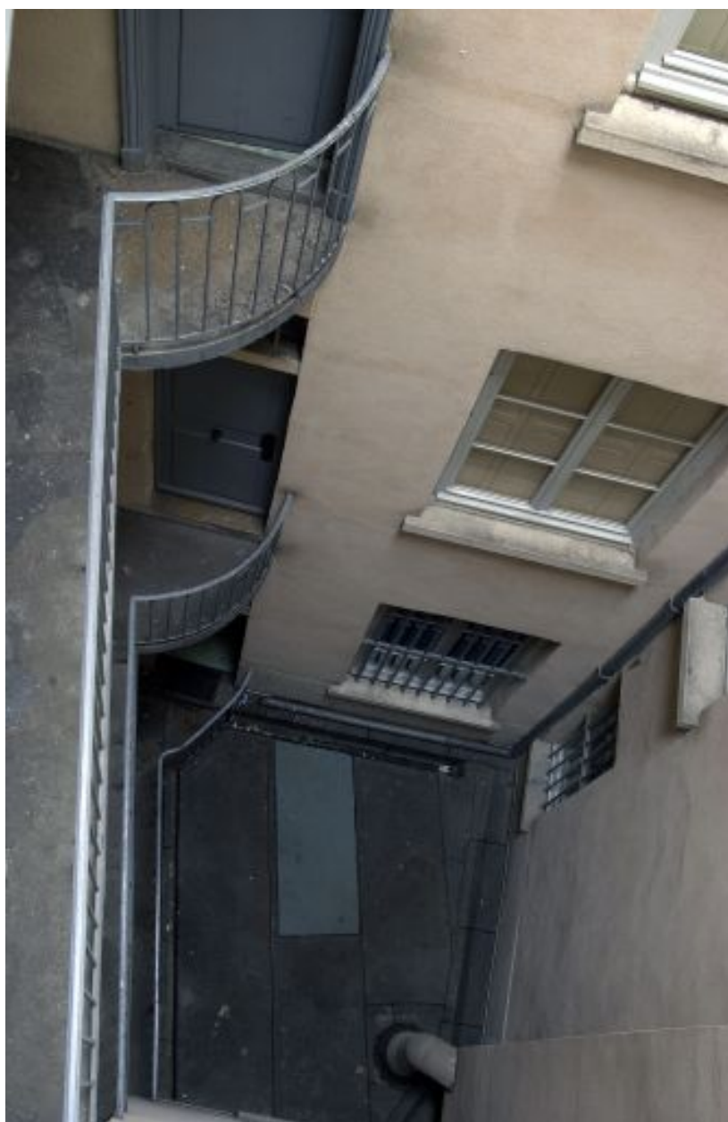
Vue générale de la cour et des paliers de l'escalier
